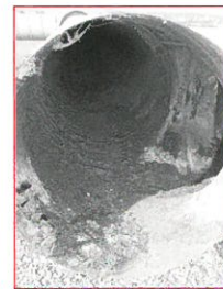
Niveau d'encrassement de conduits aérauliques sans entretien
