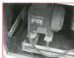
Etat intérieur d'un caisson
