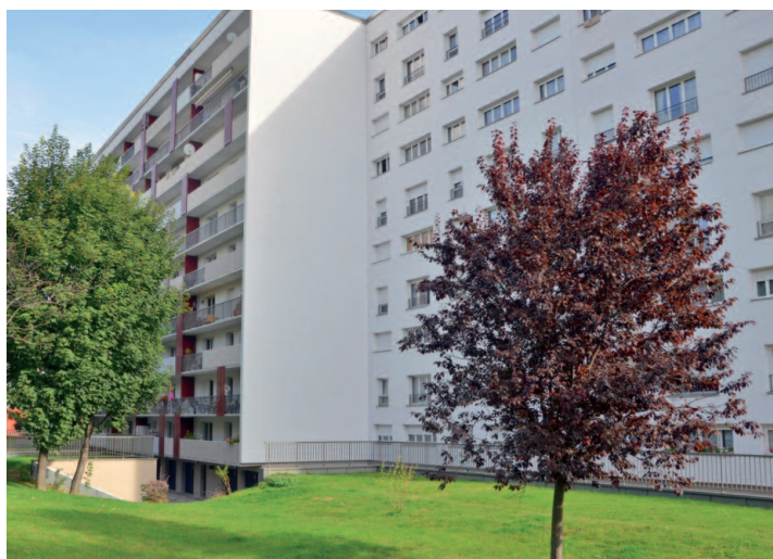
Les travaux qui ont duré 18 mois ont permis d'améliorer l'esthétique des façades. © J. Epailard
