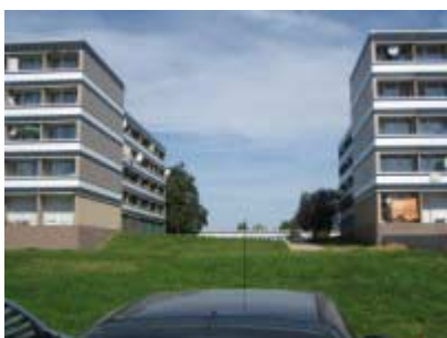
Pignon de façade après démolition
