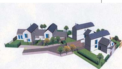
▲ Une première à Noailles : 15 villas dont 5 en location-accession construites par l'office de Brive-la-Gaillarde. Principales caractéristiques : une intégration en site classé entre le château et l'église ; création d'une zone piétonnière ; mono-murs en briques ; jardins privatifs ; toitures en ardoise dans le style du pays. © DR
