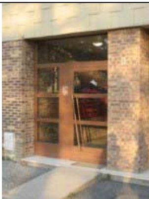
Hall avant réhabilitation
