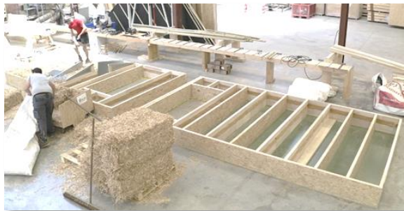
Etape 1 - Préfabrication en atelier des panneaux en ossature bois peuplier / paille
