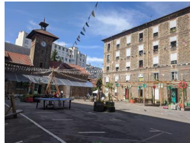
Caserne Exelmans (16 e ) Rénovation lourde
