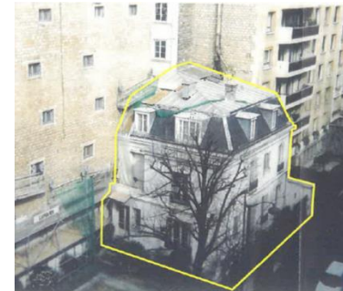
Pavillon Alfred Bruneau (16 e ) Démolition reconstruction
