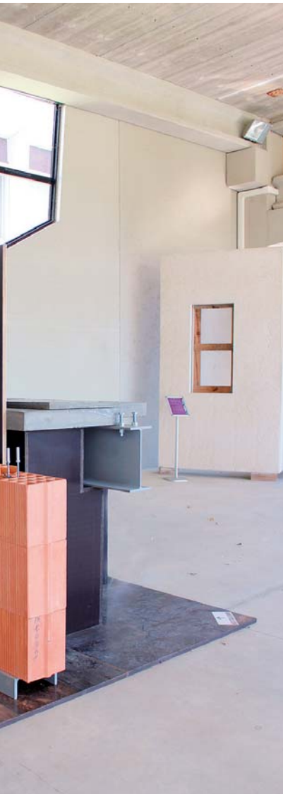
◉ Maquette du projet Demodulor , qui présente en grandeur nature quatre solutions démontables avec des matériaux divers. © Institut Carnot MECD
