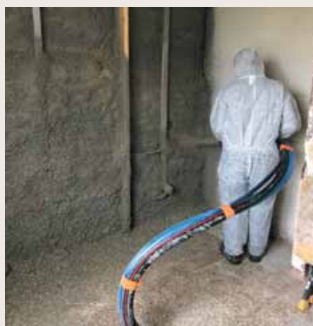
À Bully-les-Mines, opération test de réhabilitation de trois logements en béton de chanvre projeté, dans le cadre du projet Rénochanvre. © Maisons & Cités
