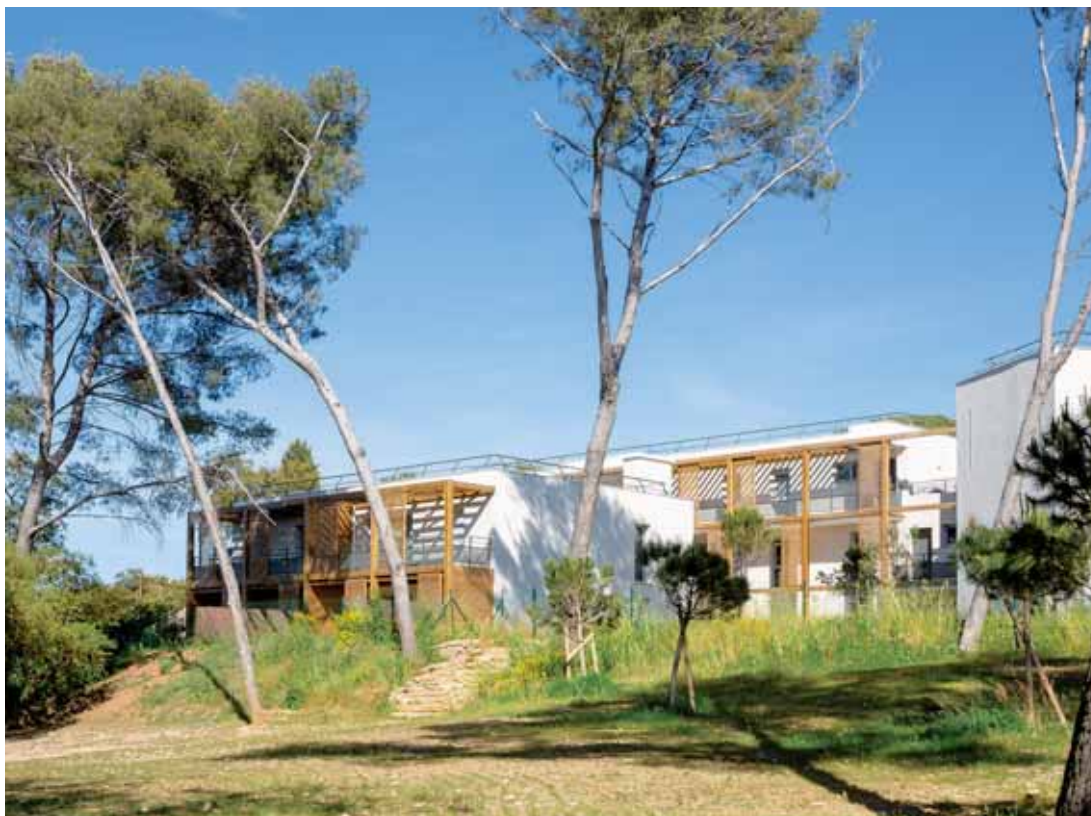
☉ Résidence Espeli à Six-Fours-les-Plages réalisée avec brise-soleil et bois en façade blanche, suivant les principes d'une conception bioclimatique. (MO : Logirem/Cogedim, arch. : Empreinte Architectes). Une des 9 opérations lauréates du Palmarès régional de l'habitat de Provence-Alpes-Côte d'Azur de 2019.
