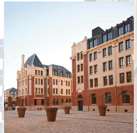
📍 La caserne laissée vide par les pompiers du Havre en 2014 a été réhabilitée en 121 logements.
