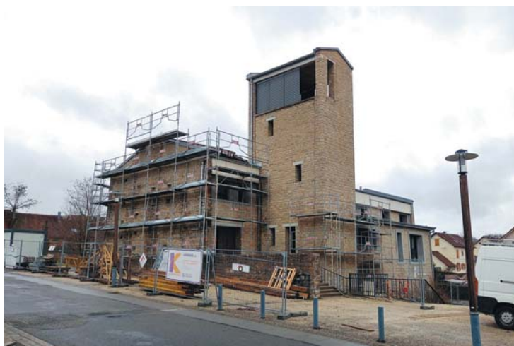
📍 L'ancien bâtiment de l'église en cours de reconversion. © Néolia
