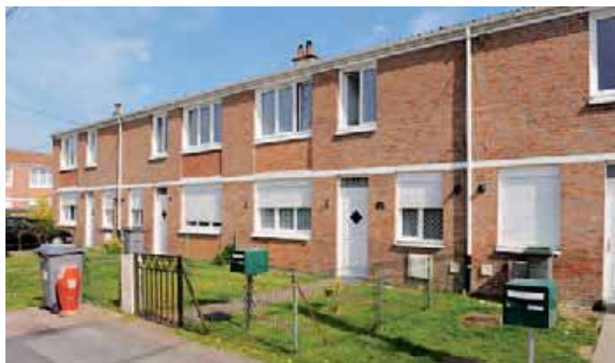
📍 Vilogia transfère plus de 500 logements à Soliha BLI HdF. Ici, à Wavrin, dans la métropole lilloise. © Vilogia
